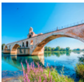
die Brücke the bridge
